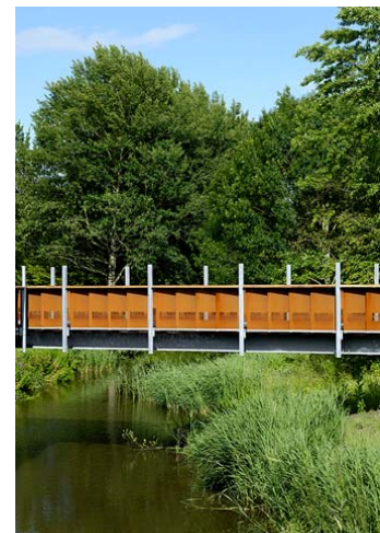
Twee loopbruggen van staal verbinden het crematorium met de begraafplaats
