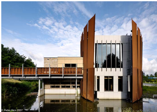
Aanzicht op Crematorium Meerbloemhof (2006) vanaf de begraafplaats en vijver. Met rechts verscholen in de CorTen schil de aula en het columbarium, links de brug en koffiekamers.
