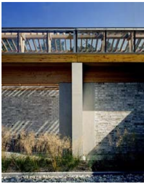
De vierkante ommuring als geleiding en bescherming.
